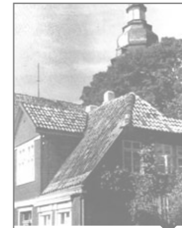
Ostertorstraße 41, Ecke Stauffenbergstraße. Hier befand sich das Ostertor, und hier wohnte der Torpförtner, 1925.
